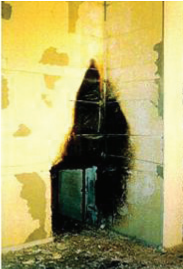
Daños en la muestra de ensayo: capa de aislamiento de PU
