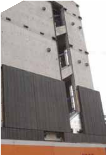
Zewnętrzne poszycie fasady montowane jak najszybciej na część izolacji, sukcesywnie w miarę postępu prac (fasada wentylowana, Manchester, UK, sierpień 2010)
